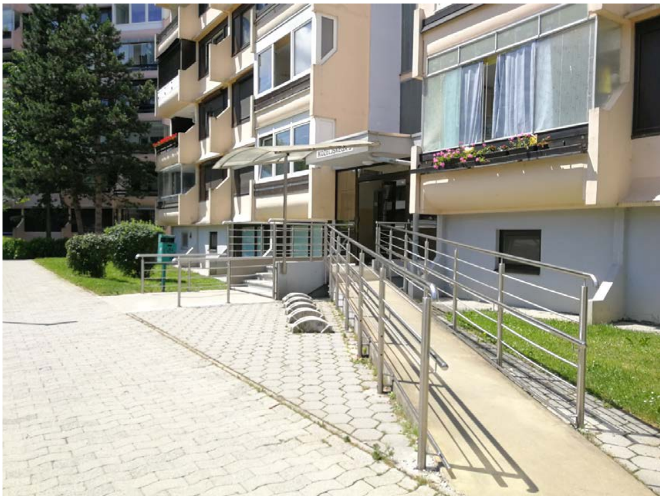
Slika 4: Urejana klančina za gibalno ovirane pred vhodom v večstanovanjsko stavbo v soseski Gorica v Velenju
